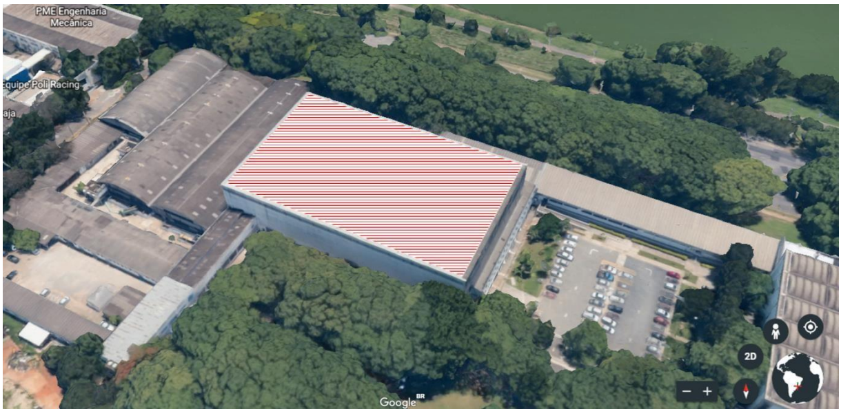
Figura 30 - Prédio da hidráulica e área disponível para a instalação de painéis fotovoltaicos
