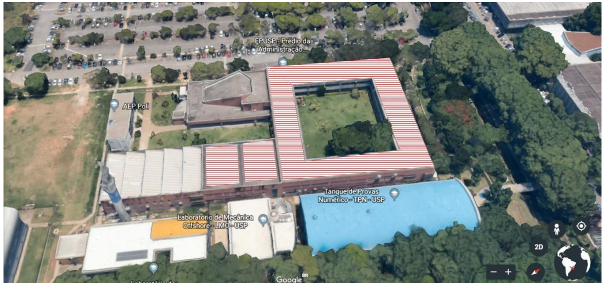
Figura 28 - Prédios da Administração e área disponível para a instalação de painéis fotovoltaicos
