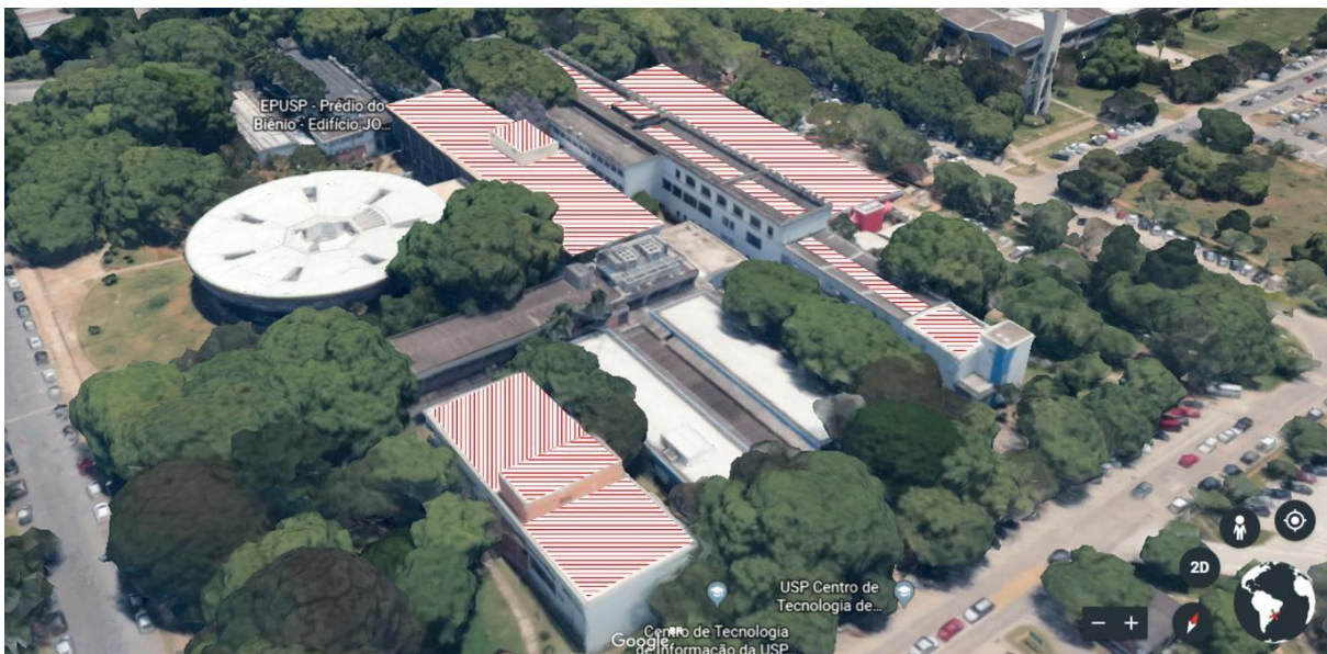
Figura 33 - Prédios do biênio e da engenharia de produção e área disponível para a instalação de painéis fotovoltaicos
