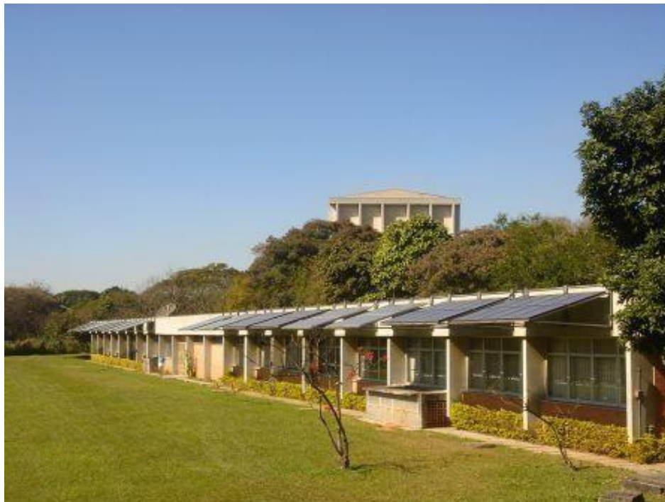
Figura 8 - Sistema instalado no prédio da administração do Instituto de Energia e Ambiente
