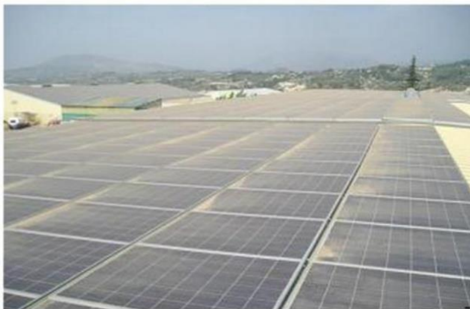
Figura 7 - Exemplo de painéis com poeira distribuída de forma não homogênea
